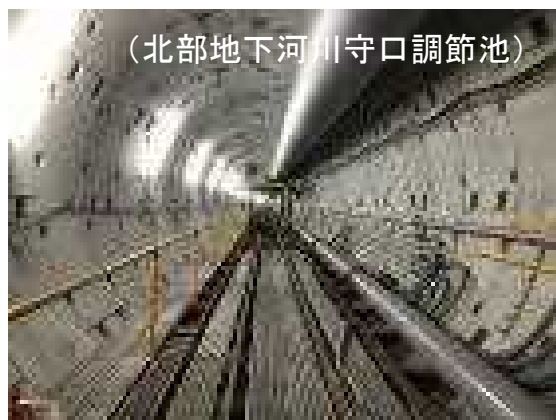
地下河川・流域調節池整備
