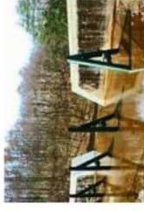
・後付式の流木捕捉工や強靱ワイヤーネットを活用した緊急整備
