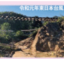
三陸鉄道 道床の流失 国土交通省「国土交通省の取組～「被災者の生活と生業（なりわい）の再建に向けた対策パッケージ」（抜粋）～」より
