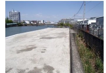
一級河川 六軒家川 防潮堤補強【完成】
