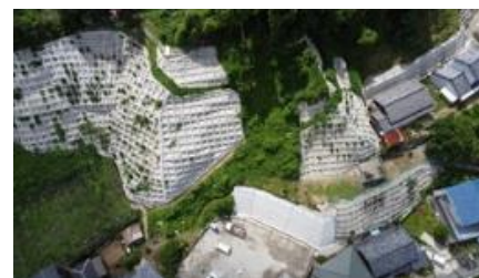
急傾斜崩壊対策事業（柏原市 畑(4)地区）
