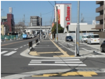
歩道の整備 府道岸和田港塔原線（岸和田市）
