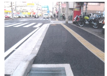
府道大阪生駒線（大東市）
