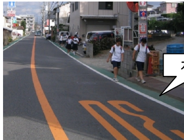
路肩のカラー化 府道春木岸和田線（岸和田市）
