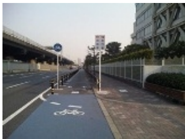
自転車道の整備 府道大阪中央環状線（門真市）
