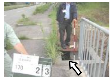
【集水桝開口部】
