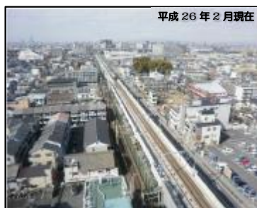
▲近鉄奈良線（東大阪市） 河内花園駅付近
