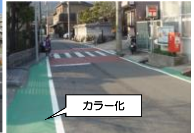
カラー化 路肩のカラー化（歩行空間の明示） 柳谷島本線（島本町）
