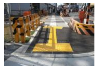
踏切内歩道設置 泉佐野熊取線（泉佐野市）
