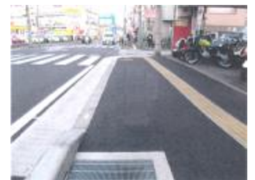
大阪生駒線（大東市）
