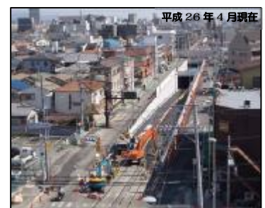
▲十三高槻線（吹田市）
