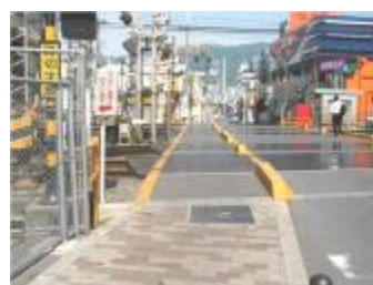
歩車道境界明示 山本黒谷線（八尾市）
