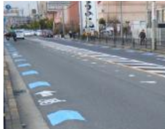
自転車レーンの設置 大阪高槻京都線（茨木市）
