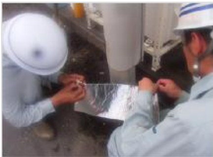
▲ 道路照明灯の修繕
