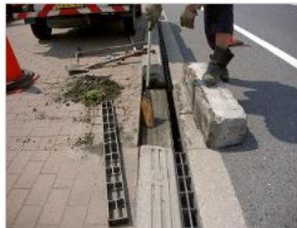
▲ 境界ブロック補修
