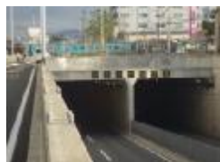
〔道路と鉄道の立体交差〕
