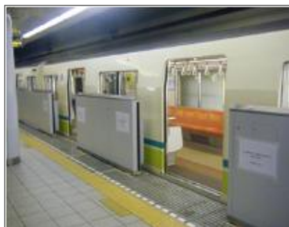
▲ 可動式ホーム柵の設置状況 （扉式）
