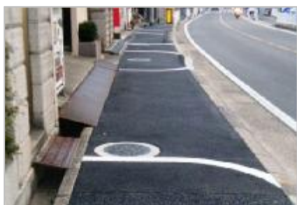
▲ 段差、勾配の改善 〔府〕大阪八尾線（東大阪市）
