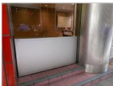
▲ 止水板の設置事例
