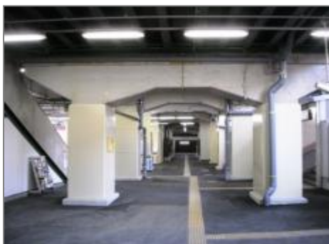
▲ 鉄道駅の耐震補強の状況
