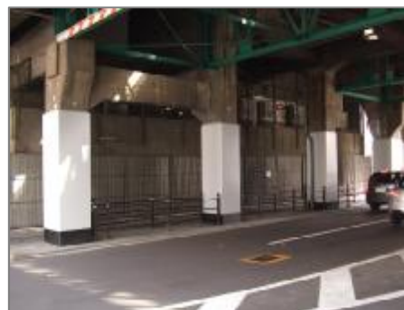
▲ 道路と交差箇所の耐震補強状況
