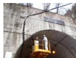
〔トンネル点検〕
