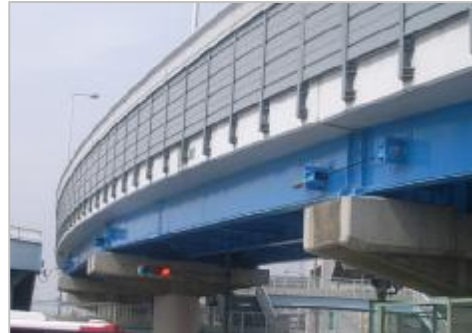
▲ 落橋防止対策
