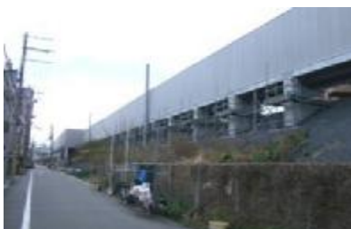
▲都島（仮称）新駅高架工事
