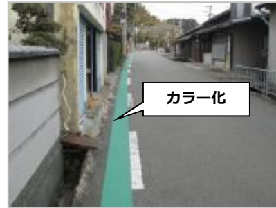
▲ 路肩のカラー化（歩行空間の明示） 〔府〕西京高槻線（島本町）
