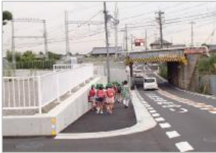
▲ 歩道の整備 〔府〕河内長野美原線（大阪狭山市）
