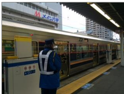
▲ 可動式ホーム柵の設置状況 （ロープ式）
