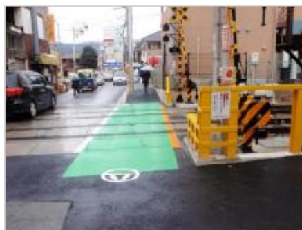
▲ 踏切内歩道設置 〔府〕桜井停車場線（箕面市）
