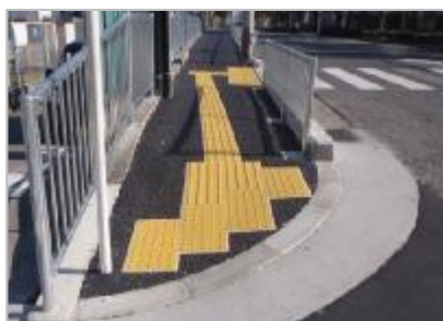
▲ 視覚障がい者誘導ブロック設置 〔府〕大堀堺線（松原市）
