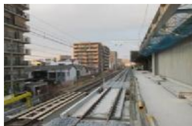
▲野江（仮称）新駅高架工事
