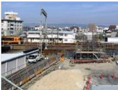
▲〔都〕堺港大堀線 （松原市）
