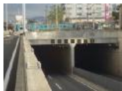
〔道路と鉄道の立体交差〕
