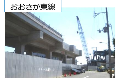
西吹田駅（仮称）付近
