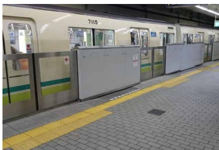
可動式ホーム柵の設置（扉式）
