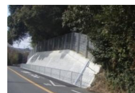
〔道路法面対策〕
