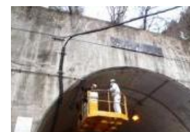
〔トンネル点検〕
