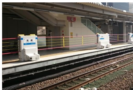
可動式ホーム柵の設置（ロープ式）
