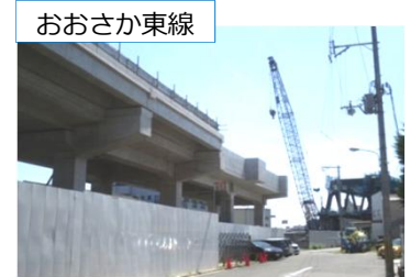
西吹田駅（仮称）付近
