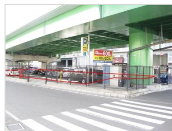
▲一般国道170号新町跨道橋高架下 (東大阪市)
