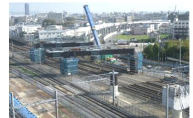
新大阪駅～西吹田駅（仮称）間
