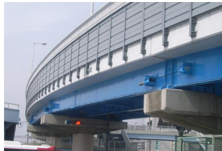
落橋防止対策
