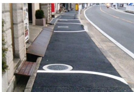
歩道の段差、勾配改善
