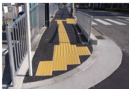
視覚障がい者誘導用ブロックの設置
