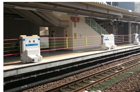
可動式ホーム柵の設置 (ロープ式)
