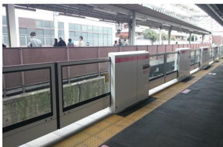
可動式ホーム柵の設置 (扉式)
