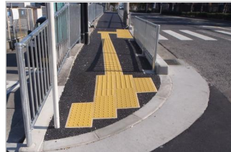
視覚障がい者用誘導ブロック設置
