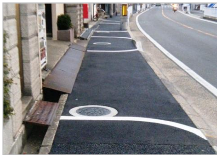
段差、勾配の改善
