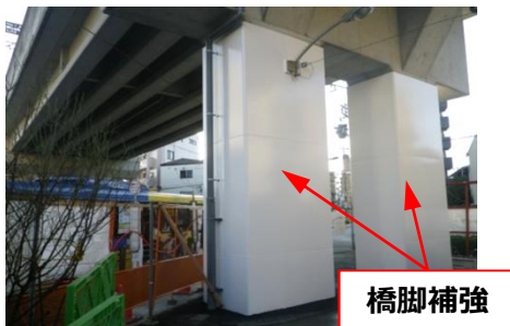
鉄道駅耐震補強の状況
