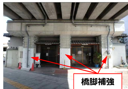
道路と鉄道が交差する箇所の耐震補強状況
