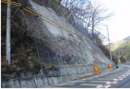
落石・法面崩壊防止対策
