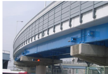
落橋防止対策
