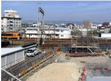
道路と鉄道の立体交差化 (〔都〕堺港大堀線・松原市)
