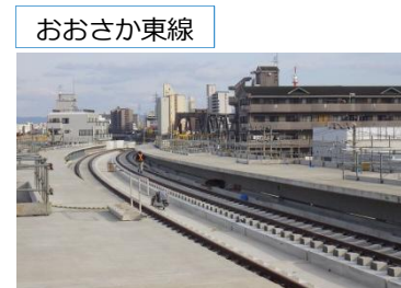
西吹田駅（仮称）付近
