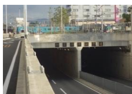
〔道路と鉄道の立体交差〕
