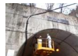
〔トンネル点検〕
