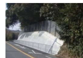
〔道路法面対策〕
