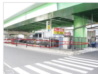
▲国道170号新町跨道橋高架下 (東大阪市)
