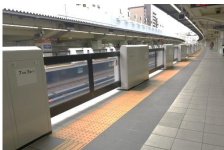
可動式ホーム柵の設置（扉式）
