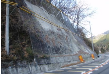
落石・法面崩壊防止対策
