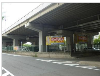
▲国道423号榎坂高架橋下 (吹田市)
