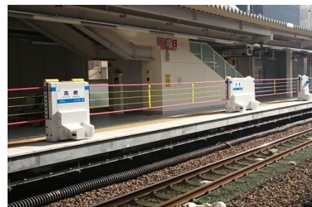
可動式ホーム柵の設置（ロープ式）
