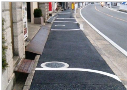
段差、勾配の改善
