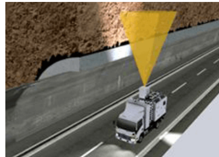
走行型画像計測（トンネル点検）
