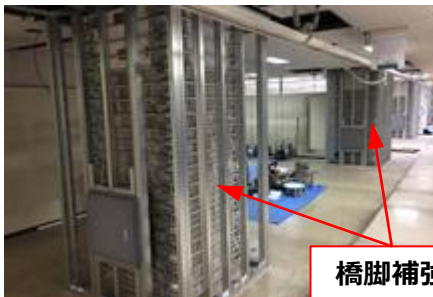
鉄道駅耐震補強の状況
