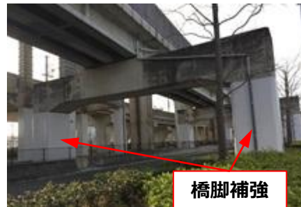
道路と鉄道が並走する箇所の耐震補強状況
