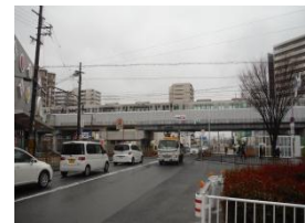
〔道路と鉄道の立体交差〕
