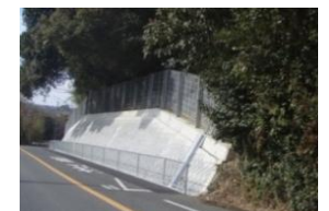
〔道路法面对策〕
