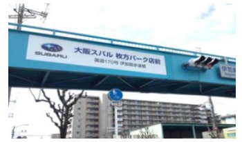
▲一般国道170号 伊加賀歩道橋(枚方市)
