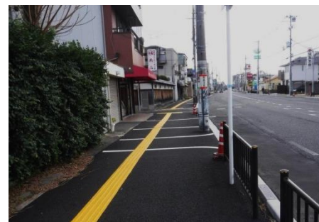
視覚障がい者用誘導ブロック設置
