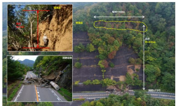
一般国道173号（福住地区）
