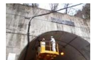
〔トンネル点検〕
