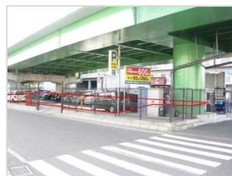
▲国道170号新町跨道橋高架下 (東大阪市)
