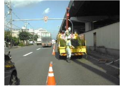
道路施設の清掃
