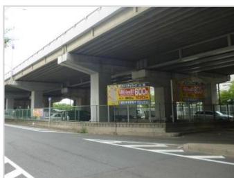
▲国道423号榎坂高架橋下 (吹田市)
