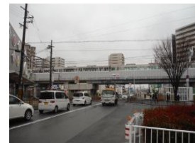
〔道路と鉄道の立体交差〕
