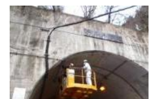
〔トンネル点検〕
