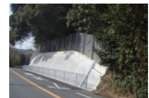
〔道路法面对策〕
