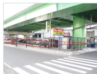
▲国道170号新町跨道橋高架下 (東大阪市)
