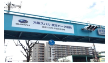
▲一般国道170号 伊加賀歩道橋(枚方市)
