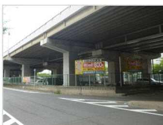
▲国道423号榎坂高架橋下 (吹田市)
