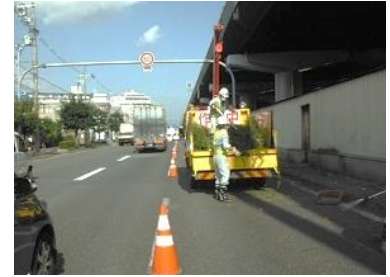
道路施設の清掃
