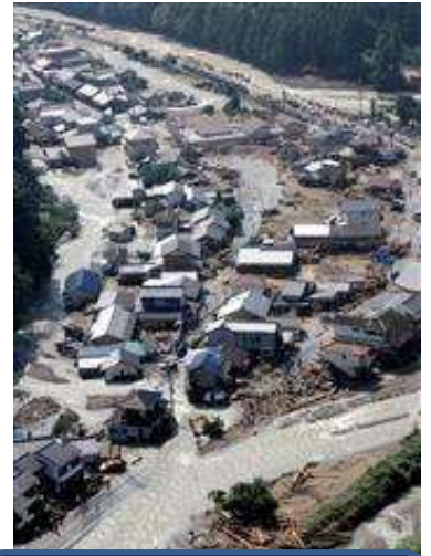
紀伊半島・大水害 (H23年・台風12号)
