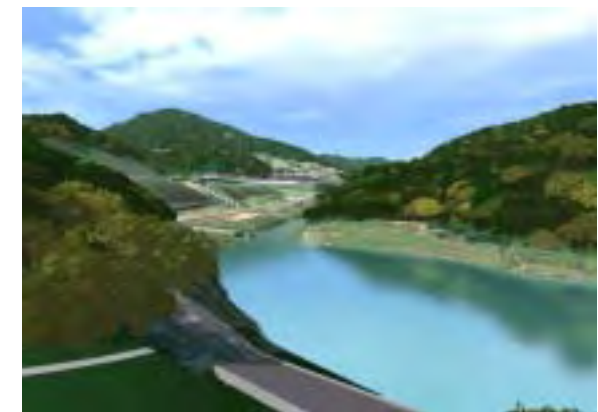
上流側より左岸の棚田跡地を望む 正面が既存橋の登龍橋
