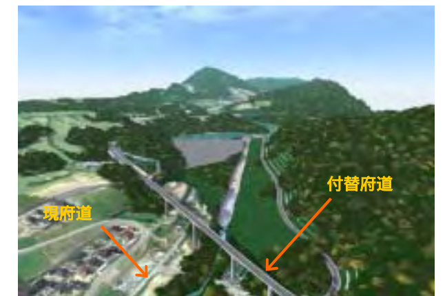
ダム堤体下流付近を南から望む
