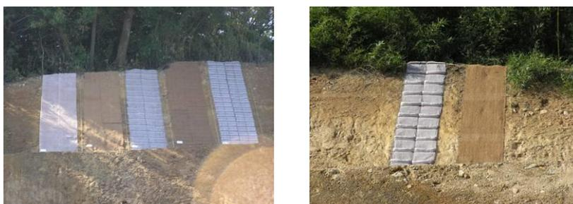
図 4.2-5 法面植生回復試験施工の状況（大岩地区残土搬入路法面）
