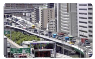
写真：阪神高速道路(阿波座合流部)
