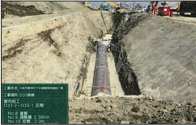
【7】下水管敷設工事の状況
