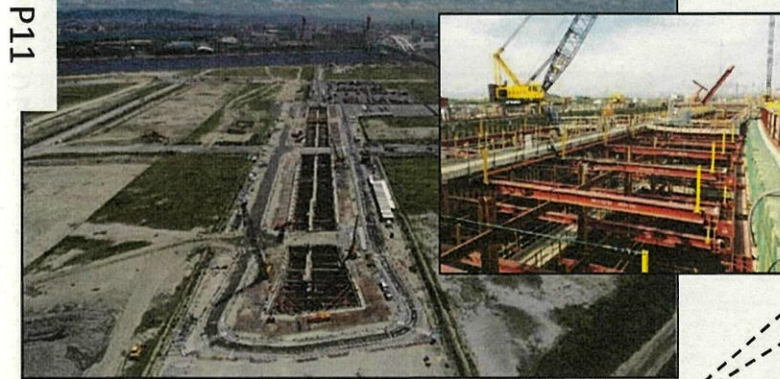
【10】鉄道駅舎建設工事の状況
