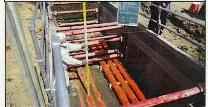
【9】電気管路敷設工事の状況
