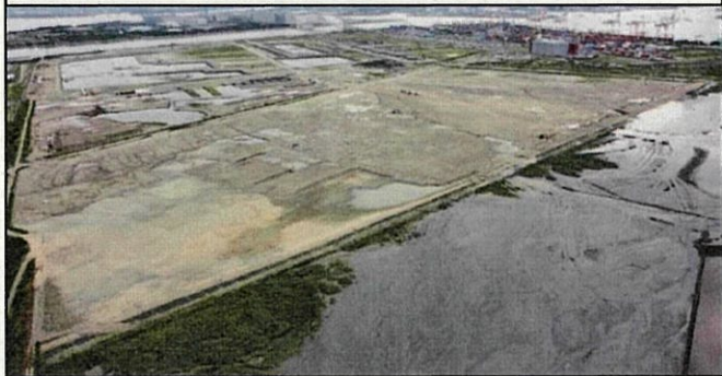
【1】【2】埋立・盛土工事の状況
