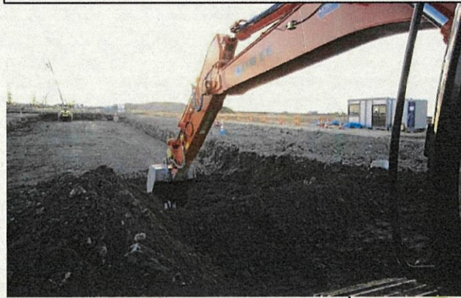
【5】観光外周道路新設工事の状況
