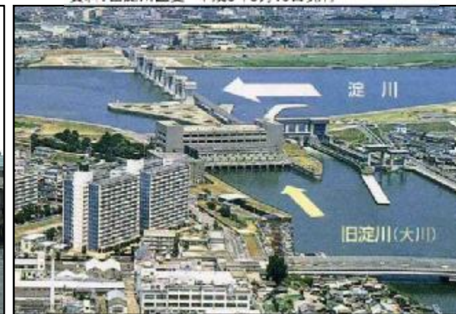
毛馬排水機場
