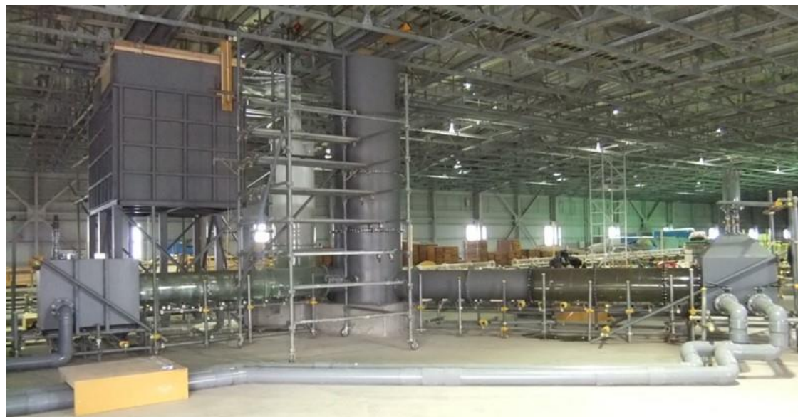
合流部・全体模型完成状況
