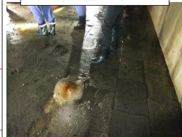
着水部の保護工(最下段)
