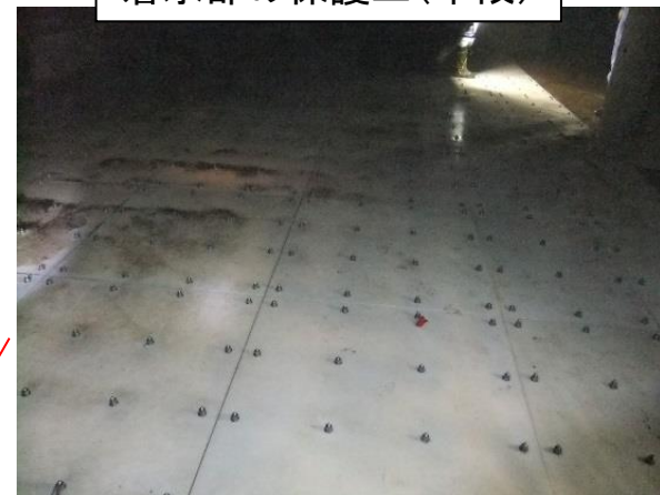
着水部の保護工(中段)
