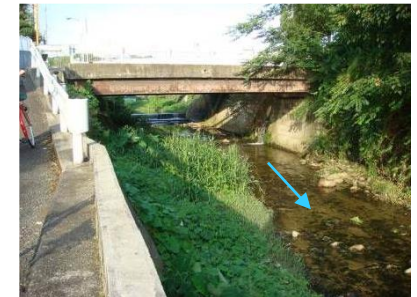
改修前(新上渡場橋下流)
