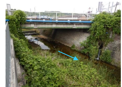
改修後(新上渡場橋下流)
