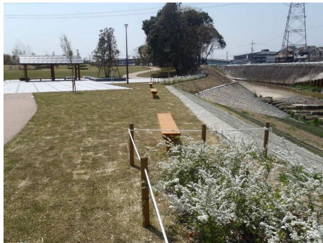
穂谷川: 芝生緩傾斜護岸(川原広場)
