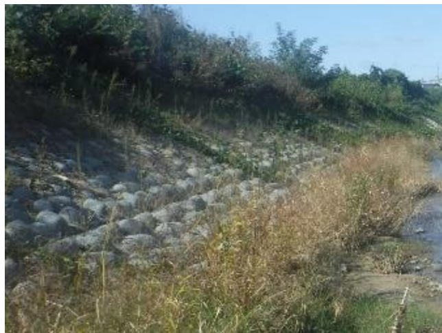
穂谷川:護岸に多孔質な張ブロックを採用
