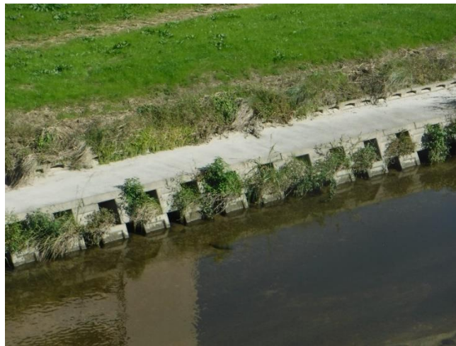
天野川:低水護岸に魚巣ブロックを採用
