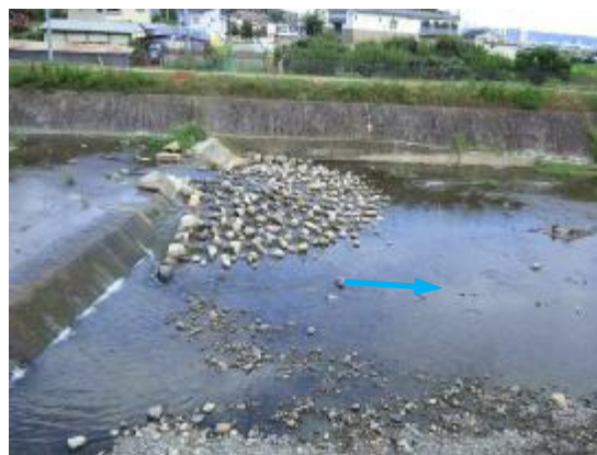
田刈揚水井堰
