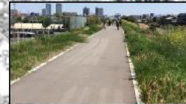
遊歩道(管理用通路)の整備
