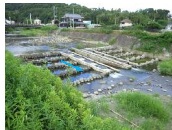
田刈揚水井堰
