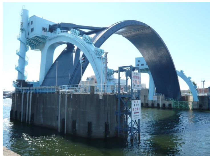
尻無川水門(昭和45年11月完成)
