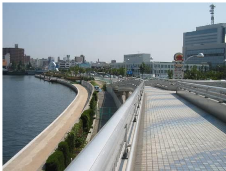
図-1.12 木津川・尻無川スーパー堤防区間
