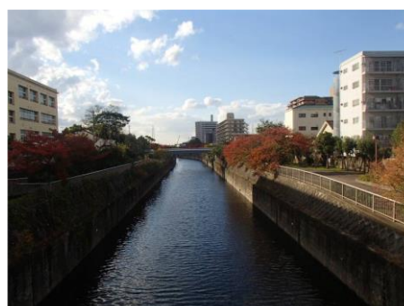
図-1.18 住吉川水門上流側
