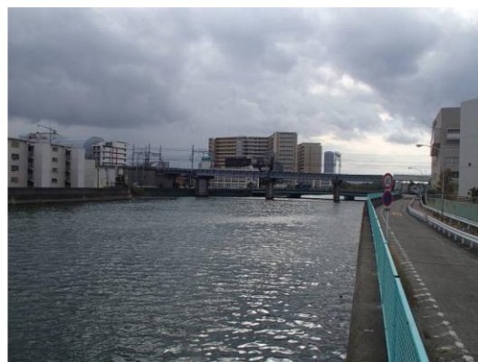
図-1.26 北港通下流
