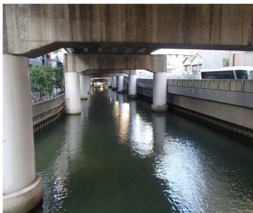
図-1.19 上大和橋下流
