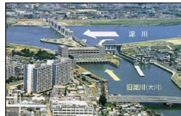
毛馬排水機場
