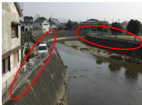
東除川改修前
