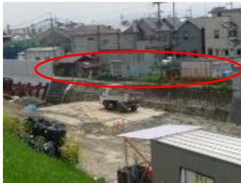
落堀川改修前
