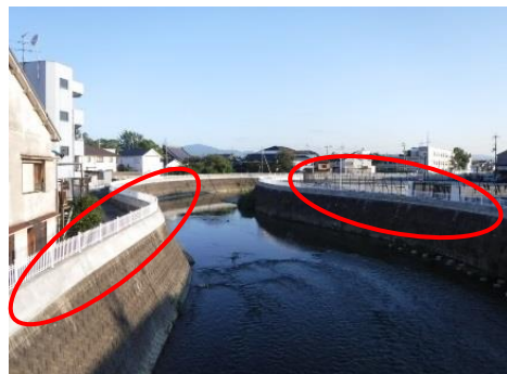
東除川改修後
