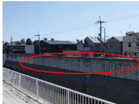
落堀川改修後
