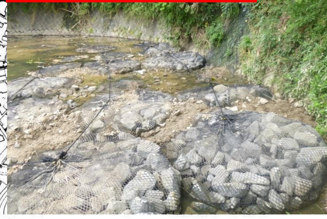
② 局所洗掘対策 袋詰玉石の設置状況
