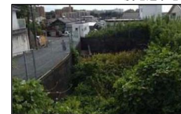
高塚台住宅調整池
