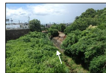
青池橋より下流を望む (雨山川)
