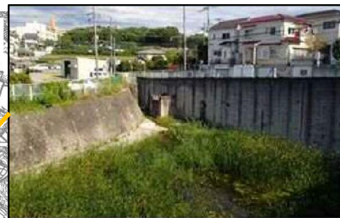
グリーンヒル住宅調整池
