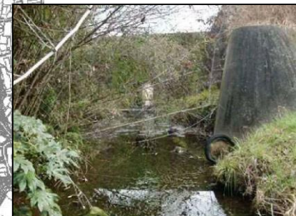
○山の手台住宅調整池
