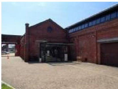
熊取交流センター煉瓦館
