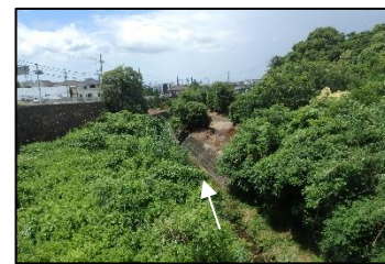
青池橋より下流を望む (雨山川)
