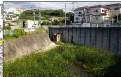
グリーンヒル住宅調整池
