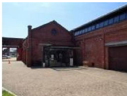
熊取交流センター煉瓦館
