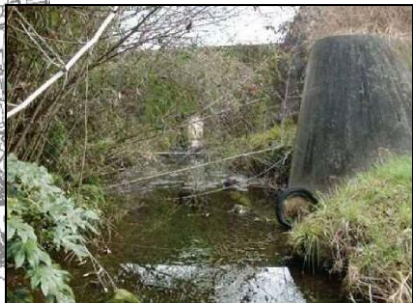
○山の手台住宅調整池
