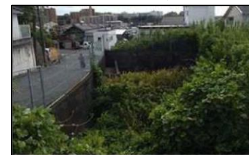
高塚台住宅調整池
