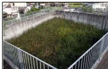
青葉台住宅調整池
