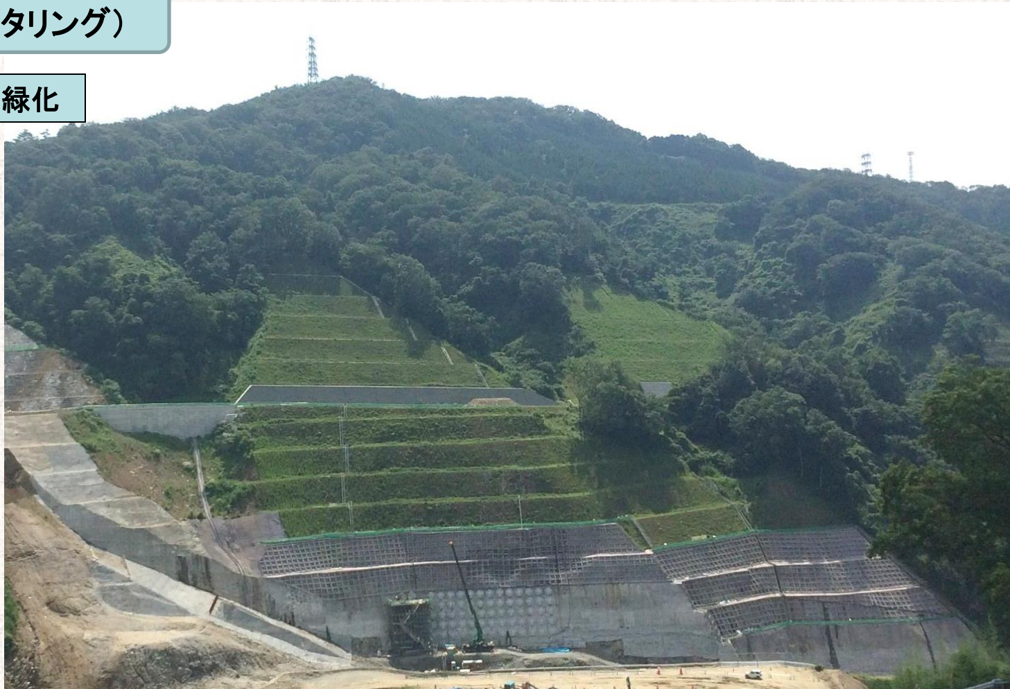
左岸道路法面(ダム直下部)
