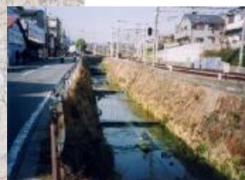
⑧糸田川 吹田市泉町 豊津駅付近
