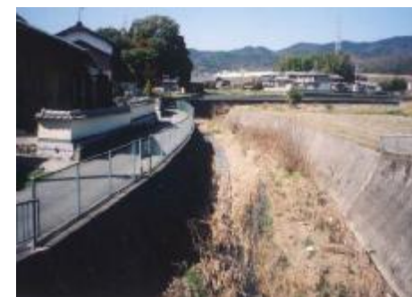
①川合裏川 箕面市粟生間谷 川合裏川上流
