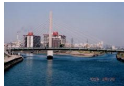
①神崎川・安威川 東淀川区相川 高浜橋下流
