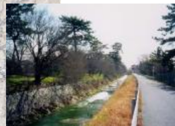
⑥高川 吹田市江坂 高川水路橋下流
