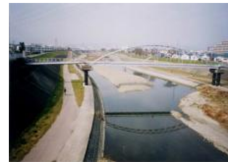
③安威川 茨木市床 千歳橋上流点
