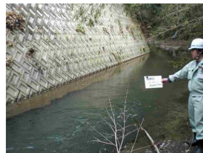
河川管理施設の点検
