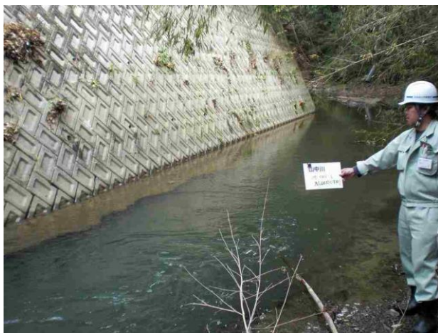
河川管理施設の点検
