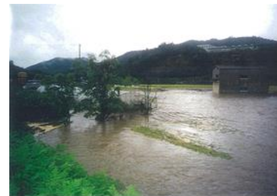
③浸水状況（田尻川当刈橋付近） H10年9月洪水流の氾濫により堤内地が浸水
