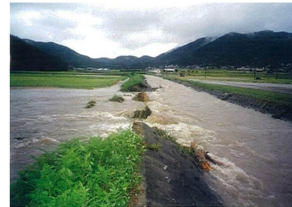
①破堤状況（田尻川当刈橋上流付近） H10年9月右岸側の堤防が破堤し、洪水流が堤内地に氾濫
