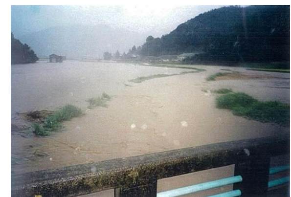
④浸水状況（蹄橋上流） H10年9月洪水流が氾濫
