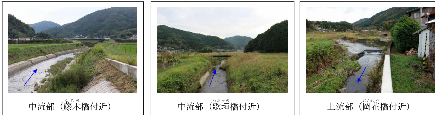
図-1.25 田尻川の河道状況
