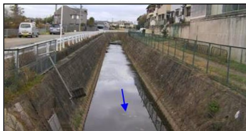
写真② 芋川 (西原橋上流部)
