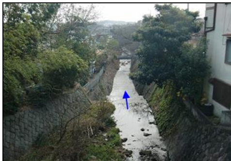
写真① 石澄川（石澄川橋下流部）
