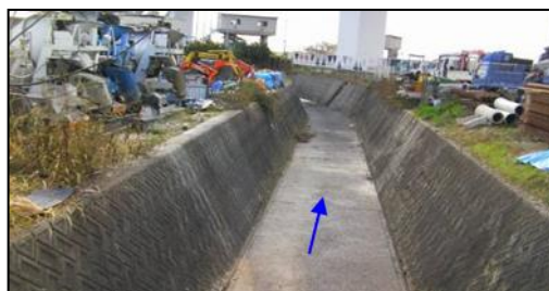
写真① 神田排水樋門上流
