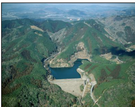
写真③ 箕面川ダム
