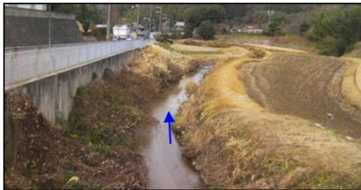
写真① 木代川（新木代橋下流部）
