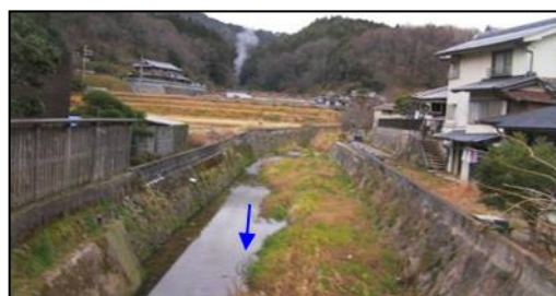
写真③ 上流部（城之越橋 しろのこし 上流部）
