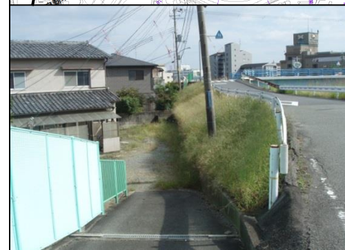
茨木川左岸1.6k付近の堤内地の状況
