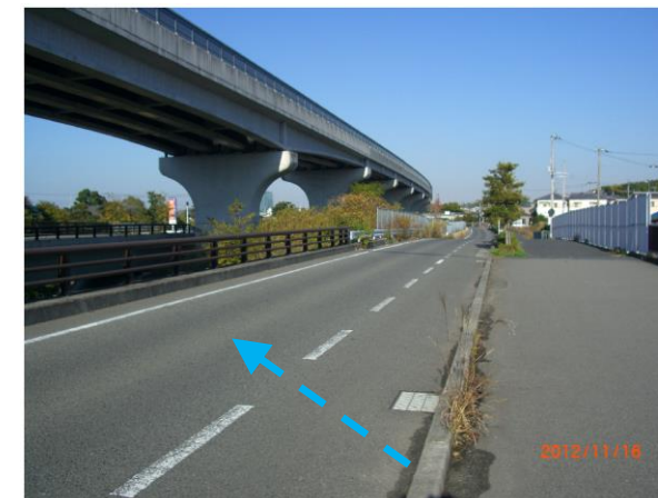
菟砥川を横断する国道 26 号
