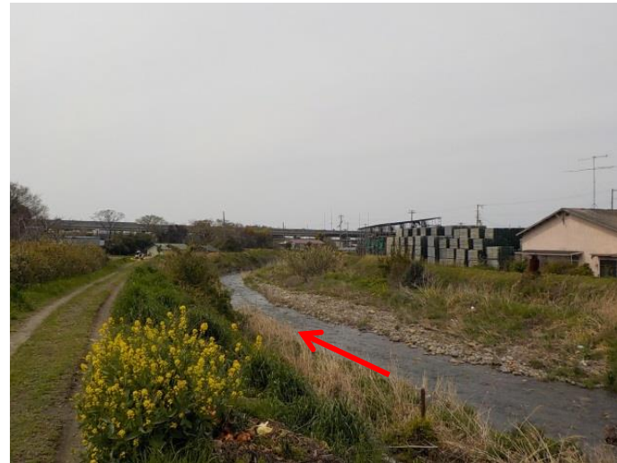
【山中川 山中橋上流】
