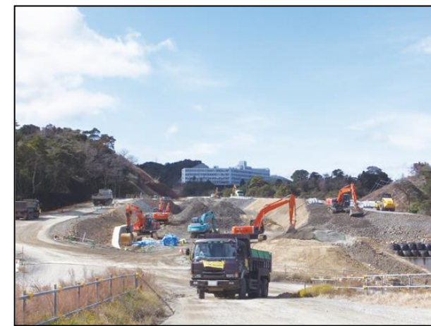
建設中の第二阪和国道（淡輪ランプ付近）
