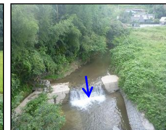
⑥ 上流端付近
