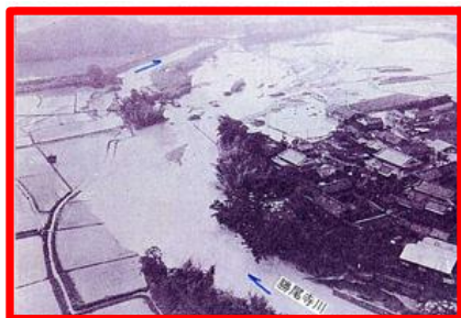
茨木川・勝尾寺川合流点付近(茨木市中河原町)
