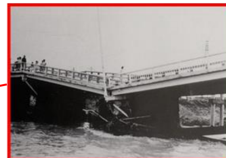
千歳橋の橋脚破損(茨木市戸伏町)
