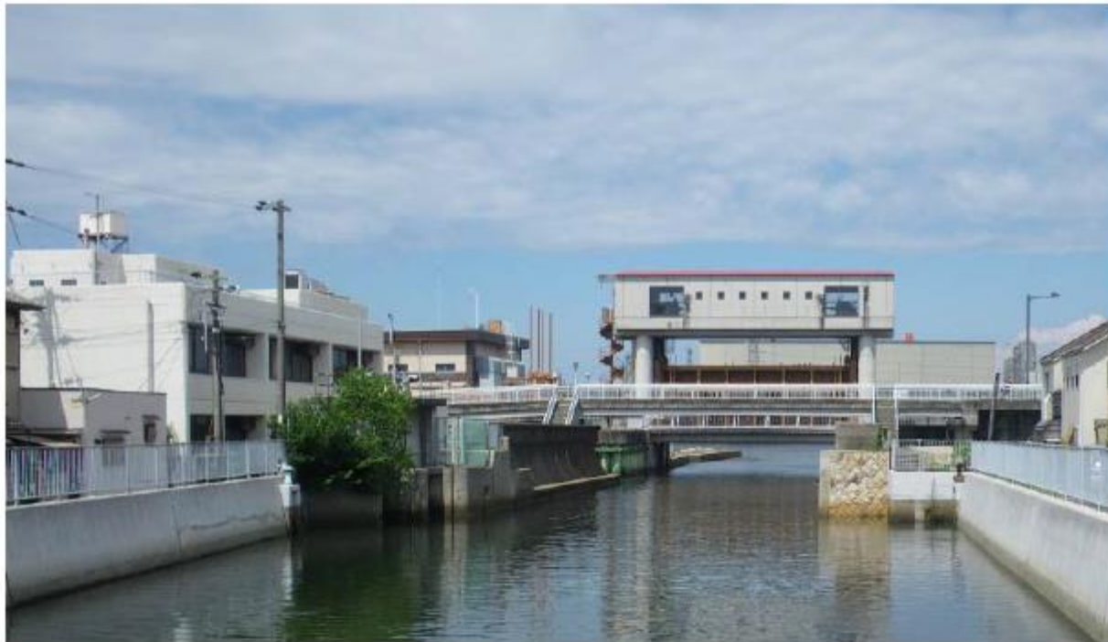
芦田川水門及び芦田川排水機場
